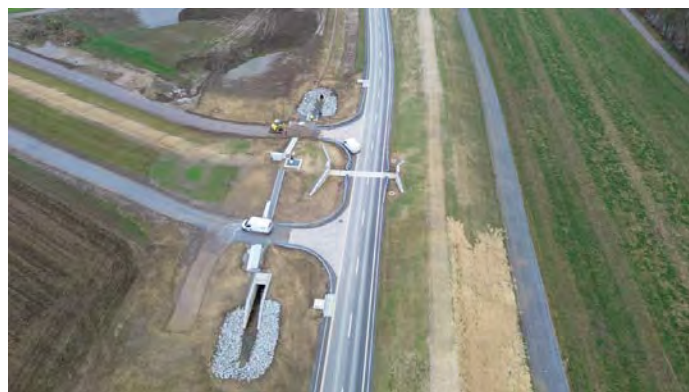
Erhöhte Kreisstraße mit Deichbalkenverschluss und Deichinnenentwässerung
