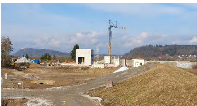
Bau des neuen Pumpwerks
